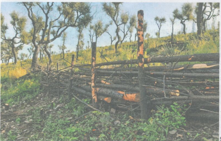
2022 a notamment été une année importante de travaux de restauration des terrains brûlés par l'incendie qui a ravagé Les Maures en 2021.
